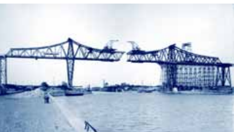
Eisenbahnhochbrücke Rendsburg im Bau
